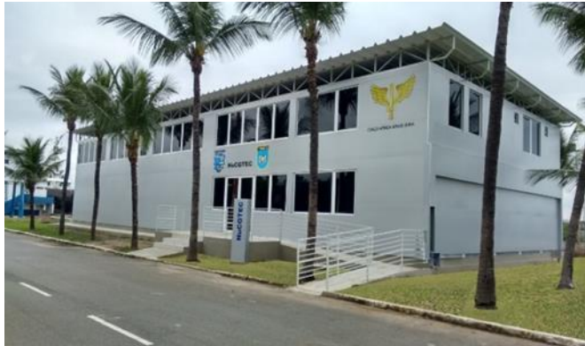
Prédio do NuCGTEC
