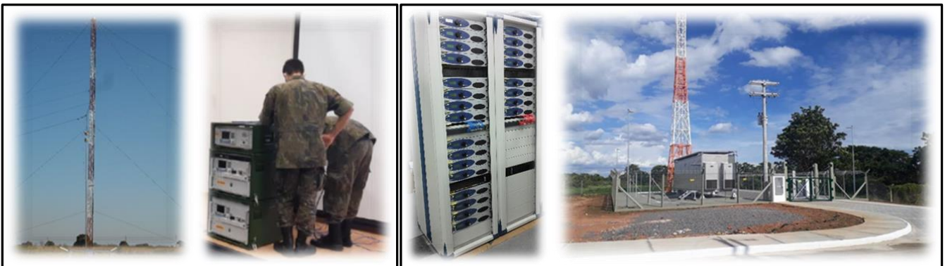
Antena e Equipamentos HF e VHF
