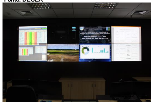
Sala Técnica do CINDACTA IV no Voo de Inspeção Remoto do ILS Boa Vista
